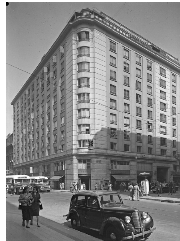
Caja Nacional de Empleados Públicos y Periodistas building. San Antonio 427. Photographs by Antonio Quintana, 1955
