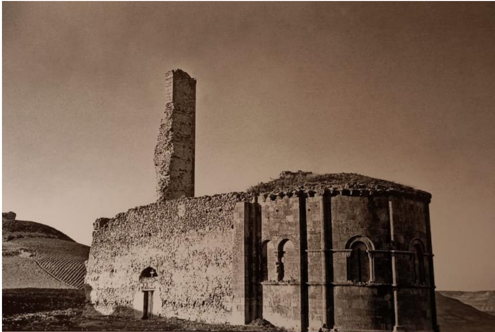
Fig.10 Apse before dismantling. Archivo General de la Administración
