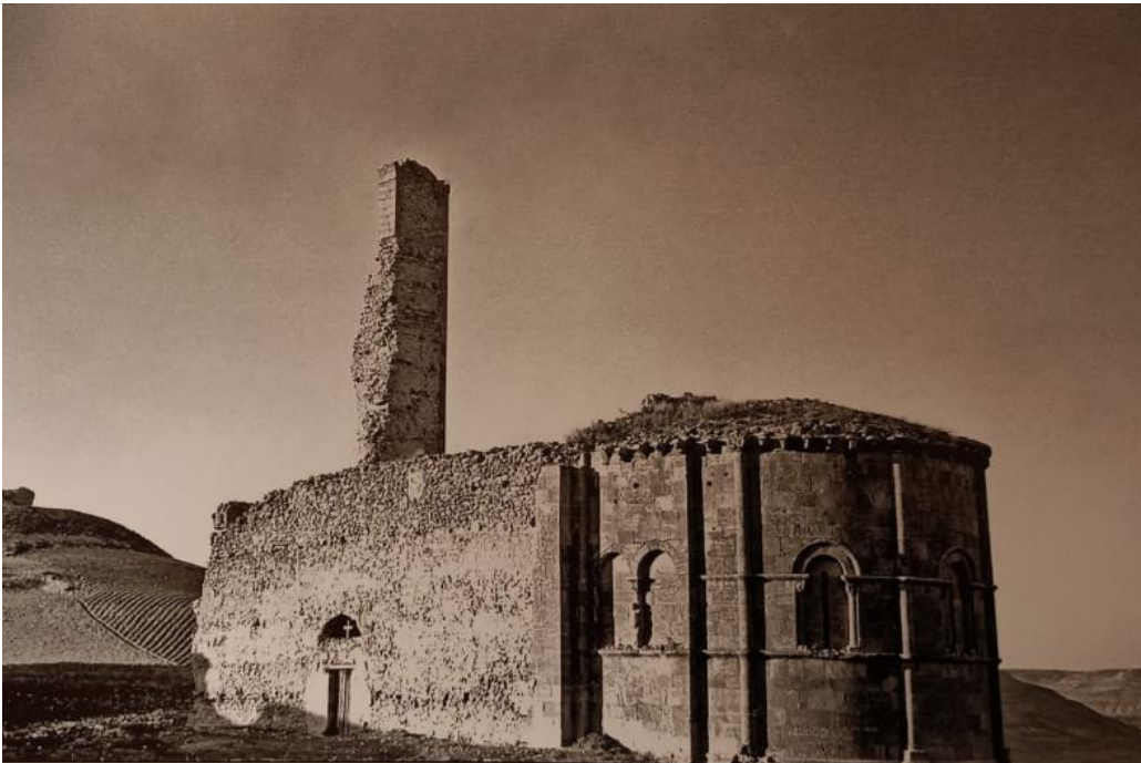
Fig. 2 San Martín before dismantling. Archivo General de la Administración
